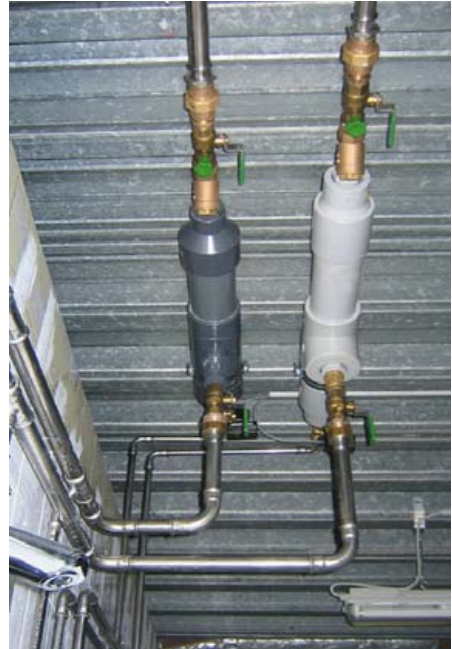
Filtri montati in seguito (esempio montaggio di un impianto docce)
